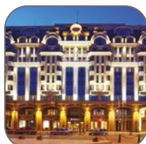
Защита высотных домов и гостиничных комплексов
